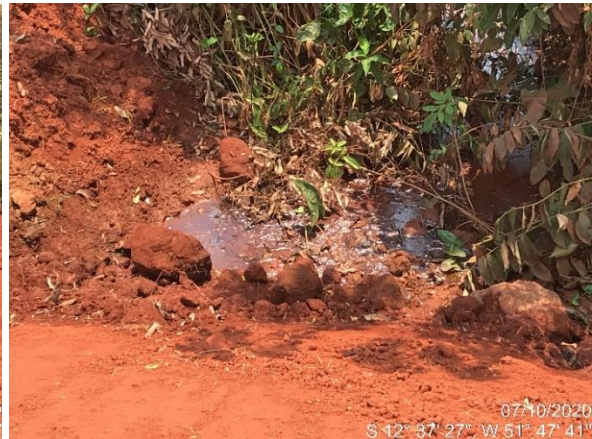
Figura 7 - Visão geral de um ponto de surgência com fluxo de água constante (pé da barragem).
