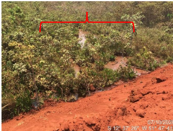
Figura 8 - Visão geral de área alagada na região a jusante da barragem (pé da barragem e faixa logo a jusante do pé da barragem)
